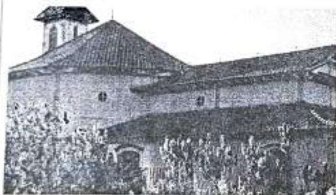
Foto 02: Vista dos fundos; observa-se os dois volumes distintos, um de partido octogonal e outro retangular.
